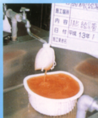
◀ 給湯管洗浄直後
